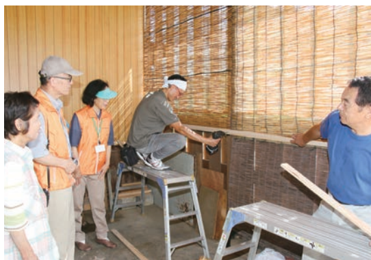
高齢者宅の玄関口にすだれを取り付ける大工
