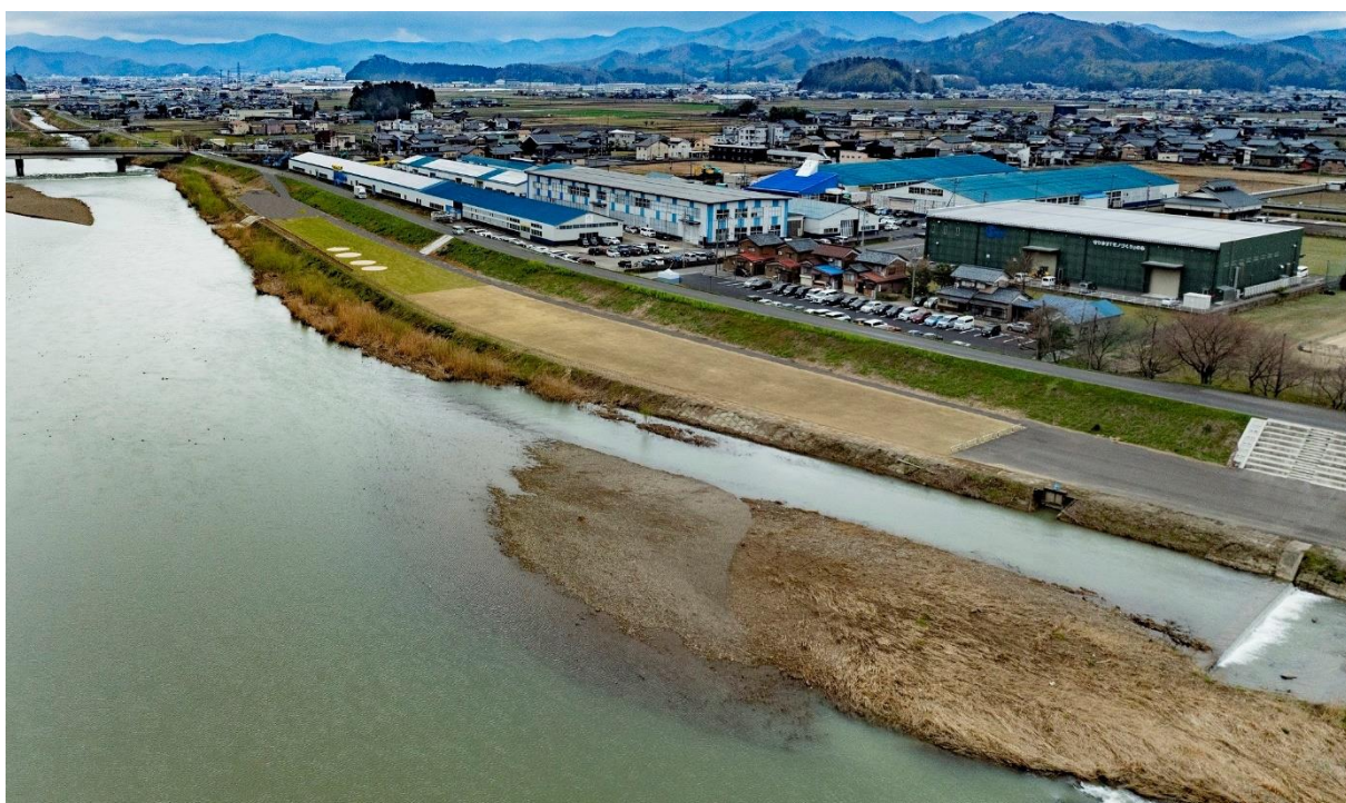
日野川緑地（左岸）完成
