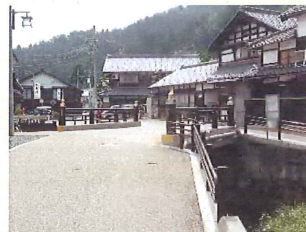
景観に配慮した高欄で架け替えた日の出橋
