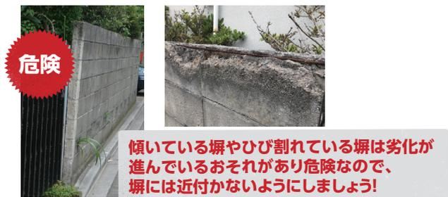
目に見えて判断できる傾きやひび割れがなくても劣化が進んでいる場合があります。塀が劣化しつつあるサインとして、ブロック表面の鉄筋の錆び汁（茶色のにじみ）や著しい白い物質の付着（ブロック内部に雨水が浸入するなどによりコンクリートの成分が溶け出し表面で白く固まったもの）があります。
