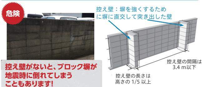
ブロック塀に対して直交に壁をつけることで、地震時に倒れにくくなります。例えばブロック塀の高さが 2m の場合は、ブロック塀の長さ 3.4m 以下（ブロック 8 個が目安）ごとに長さ 40cm 以上の控え壁が必要です。
