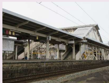
北側ホーム連絡橋
