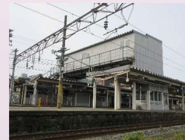
南側ホームエレベータ連絡橋
