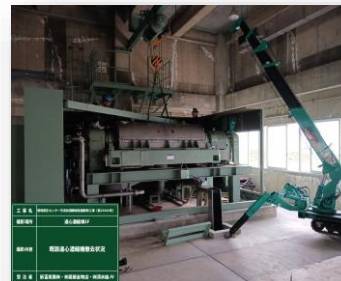
遠心濃縮機撤去
