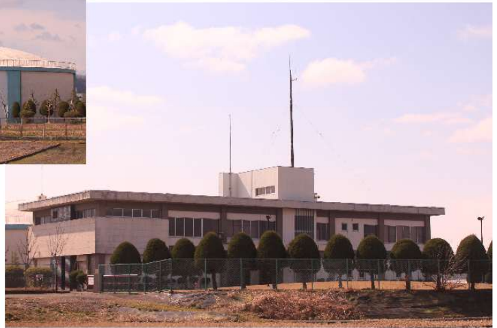
鯖江市上水道管理センター
