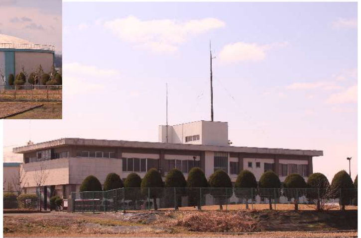
鯖江市上水道管理センター
