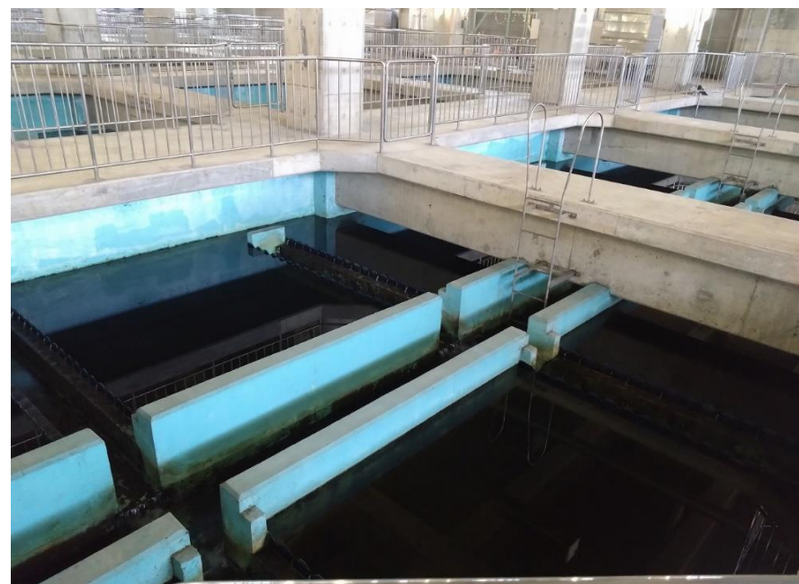
水処理施設__最終沈殿池設備
