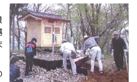
三床山の祠建設の様子
