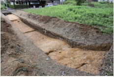
堀割の完掘状況(H30)
