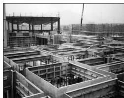
建設中の様子
