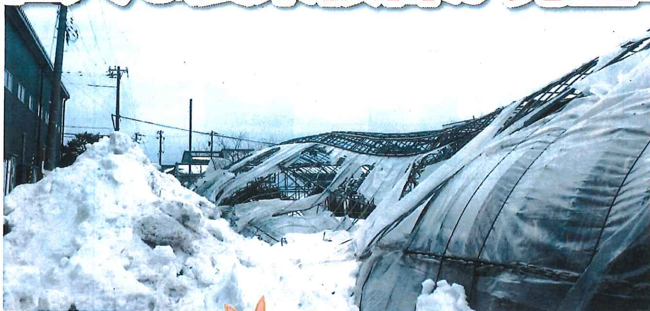
2018 福井豪雪により倒壊した 花きセンターのパイプハウス
