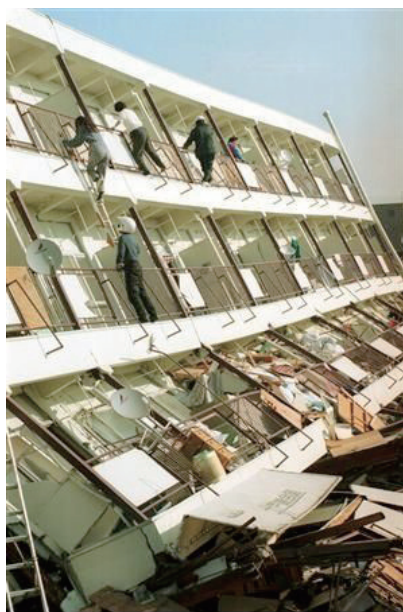
阪神淡路大震災被災現場写真 1
