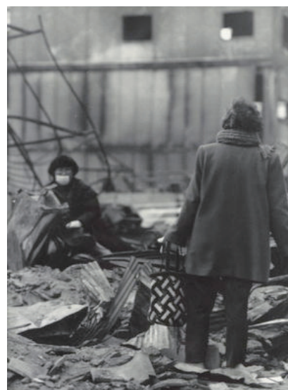
阪神淡路大震災被災現場写真3
