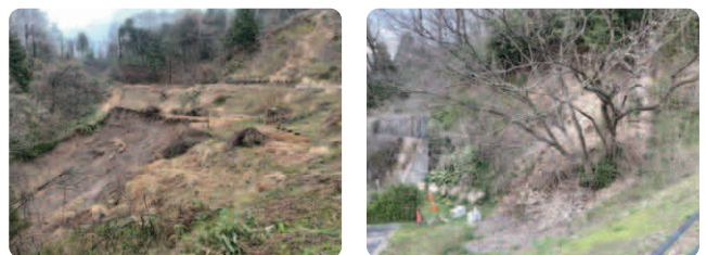
林道上河内間地線(左)および道の駅西山公園駐車場北側奥(右)の崩落の様子
