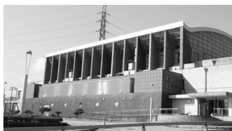
空調設備改修工事を行う鯖江市スポーツ交流館
