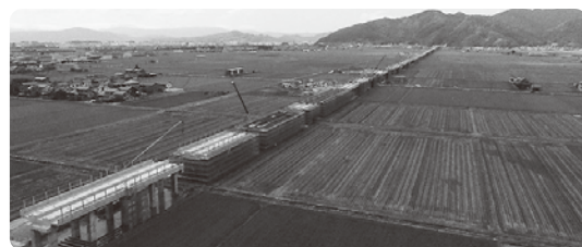
建設中の北陸新幹線(鯖江市区間)
