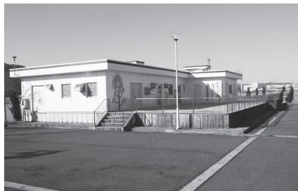
立待排水機場
