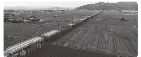
建設中の北陸新幹線(鯖江市区間)
