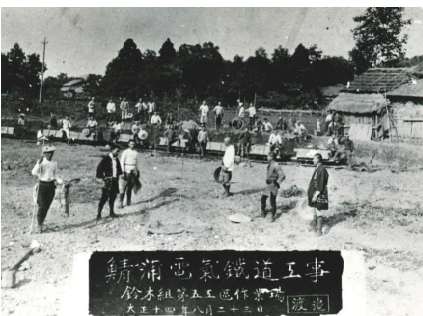
9. 工事中の鯖浦線 当時の工事作業がほぼ人力であったことが分かる。キャプションに「大正 14 年」とあるので、東鯖江-佐々生間のどこかである。
