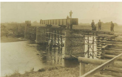
8. 建設中の鯖浦線日野川鉄橋 現在の「平成橋」である。日野川右岸(東)から平井町方向を撮影したもの。
