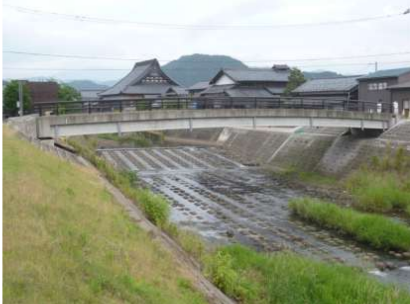
■ 河川改修工事 ... 河和田川（落井町）
