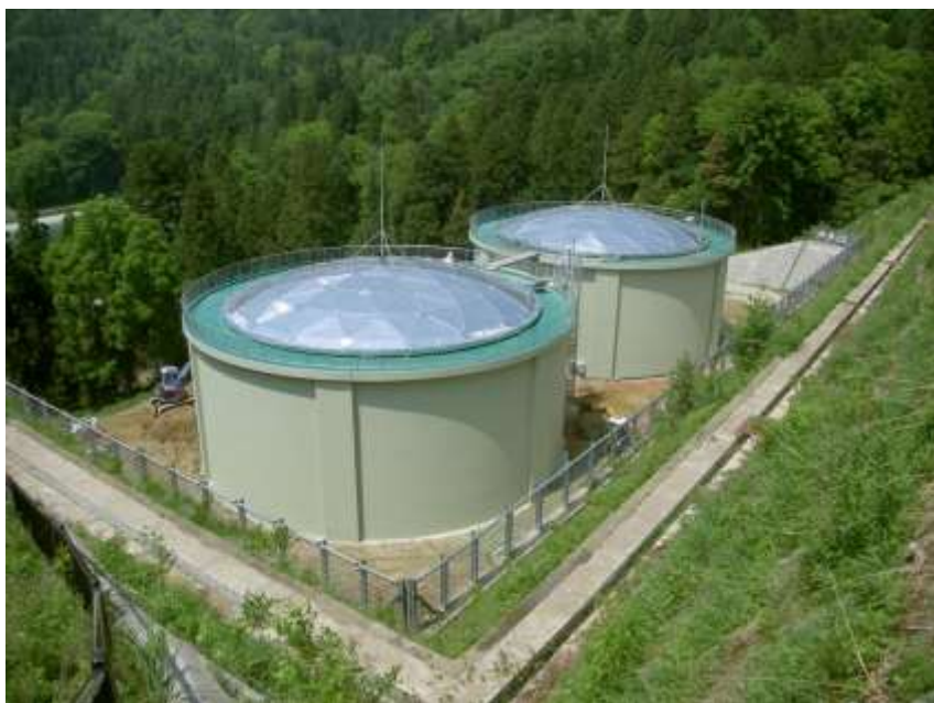
■ 下新庄配水池
