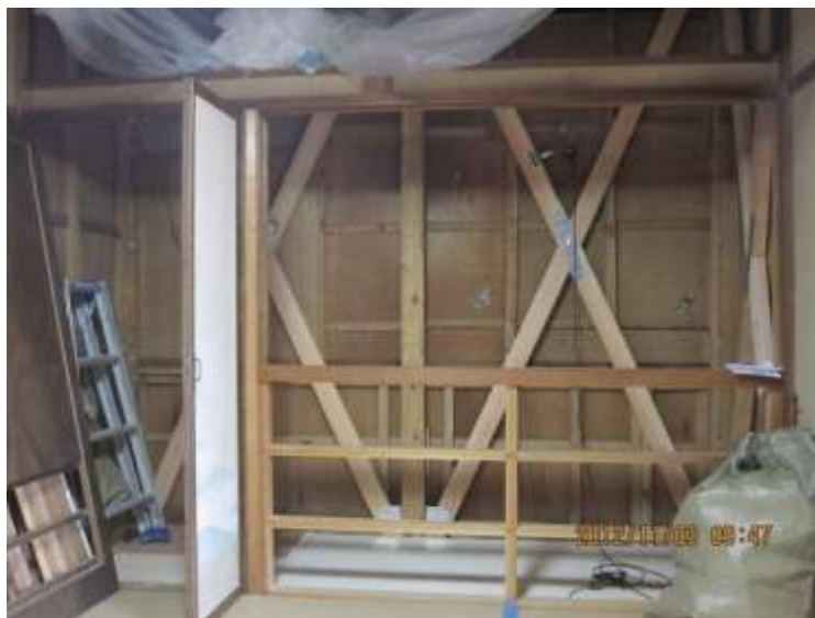
■ 木造住宅の耐震改修工事
