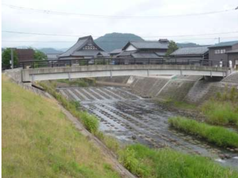
■ 河川改修工事 … 河和田川（落井町）
