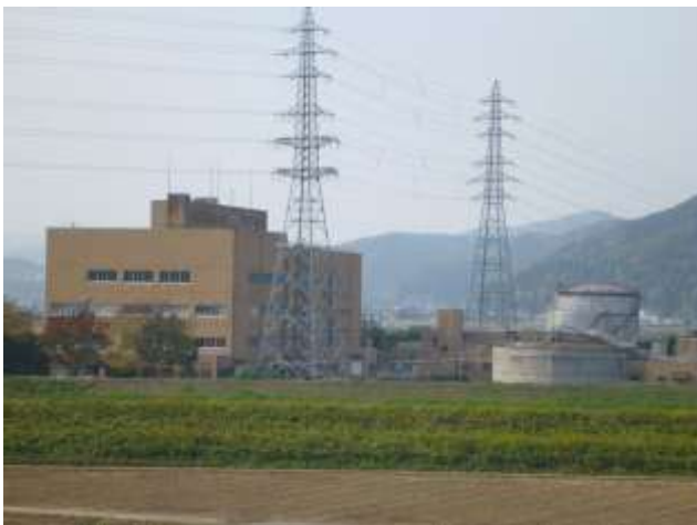
■ 鯖江市環境衛生センター
