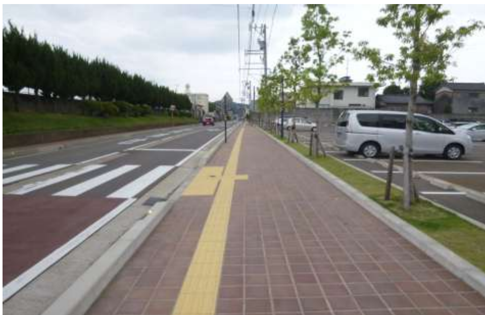
■ 幹線道路の整備 … 歩道の段差解消（バリアフリー）丸山北野線
