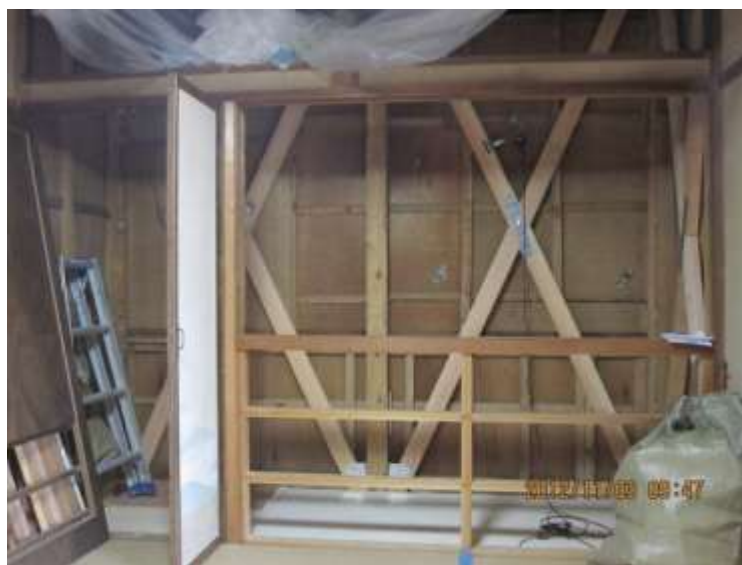
■ 木造住宅の耐震改修工事
