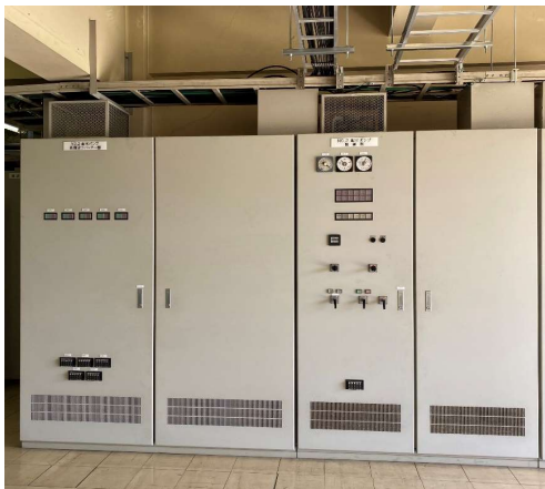
No.2 配水ポンプ盤 更新
