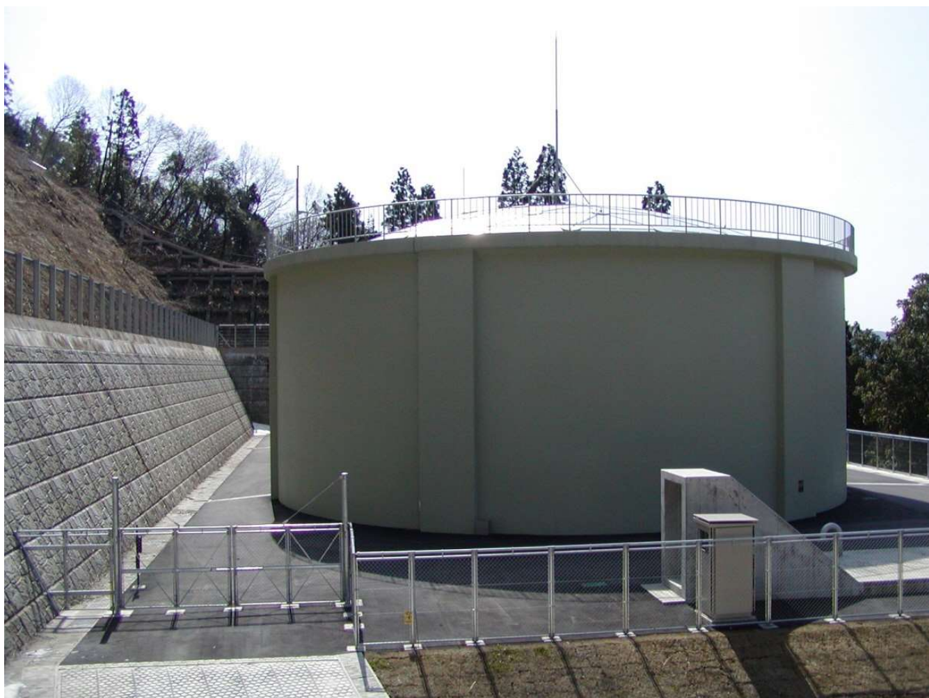
下新庄配水池
